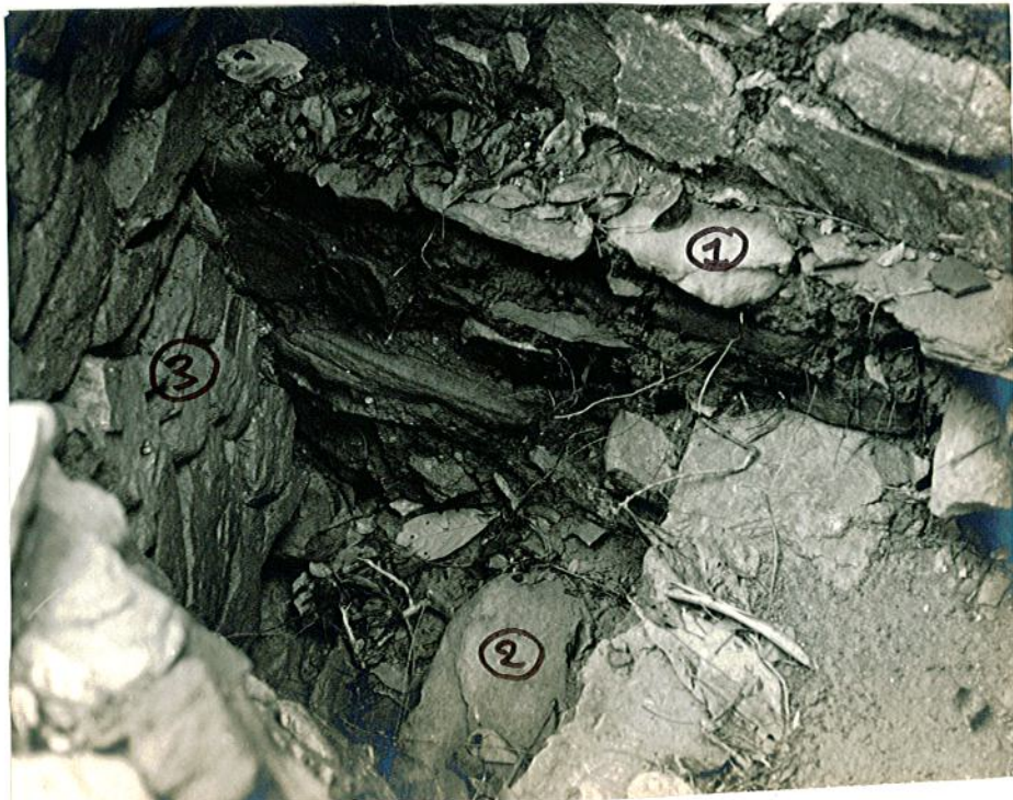
8 - ESTRUCTURA AMPLIADA. (1 - MURO ANTIGUO 2 - ESCALERA SUPRIMIDA. 3 - MURO ADICIONADO.
