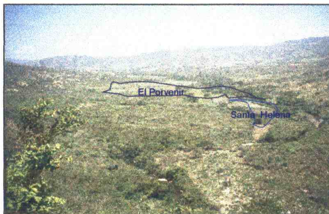
Fotografía 2 Zona de Embalse. Areas Santa Helena y El Porvenir.
