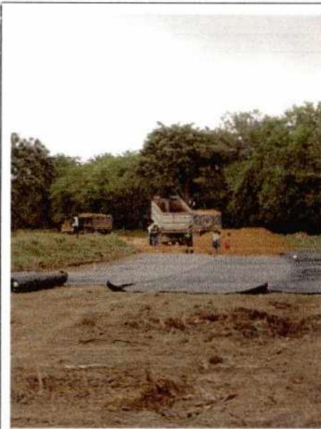
Foto 36. Proceso de construcción de la "Variante del Retiro de los Indios".
