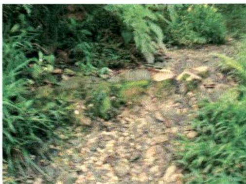
Foto 38. Confinamiento transversal de la carpeta del camino
