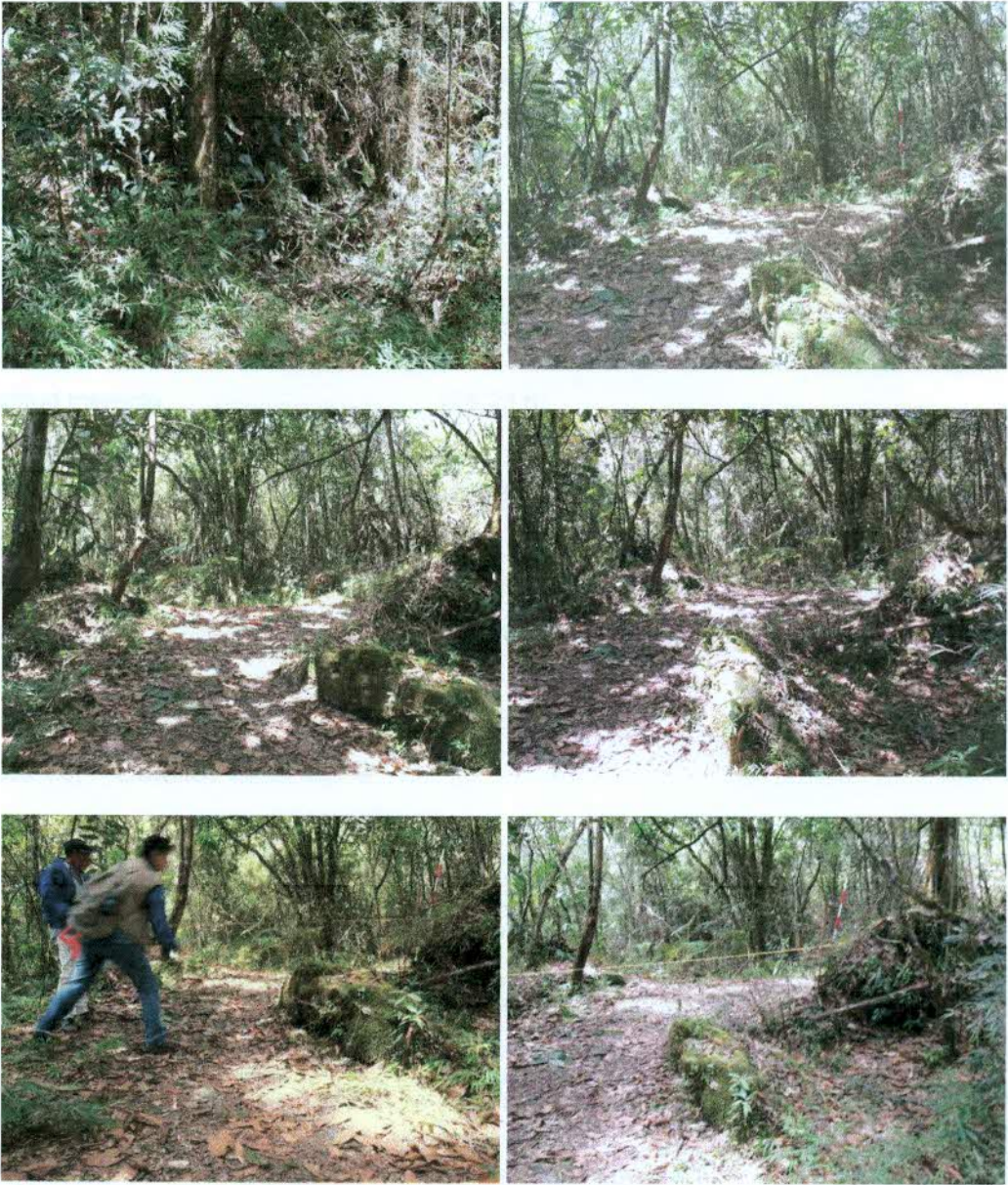
Foto 29. Muro en roca cortado por el camino.
