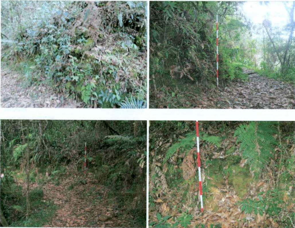
Foto 32. Muro de contención en roca
