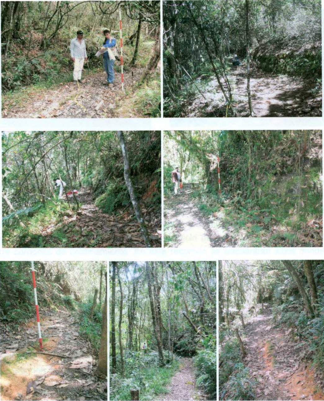
Foto 36. Calzada cuneta y carpeta
