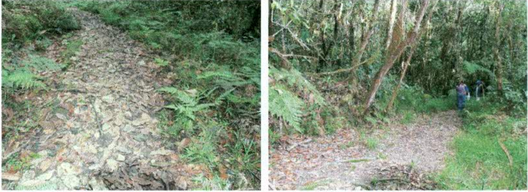
Foto 26. Calzada con carpeta y muro lateral en roca
