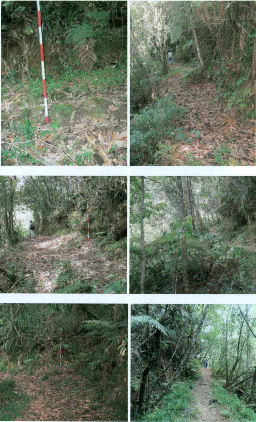
Foto 30. Detalles de pérdida de la calzada y de la carpeta en roca
