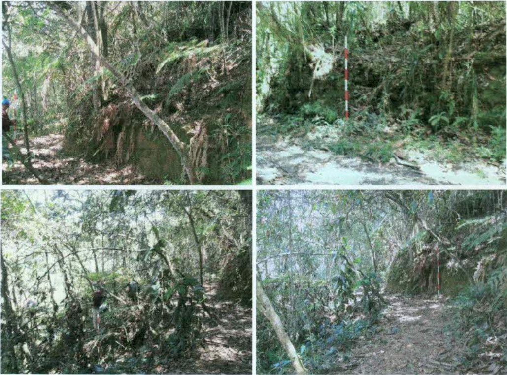
Foto 34. Muro cortado por el camino.
