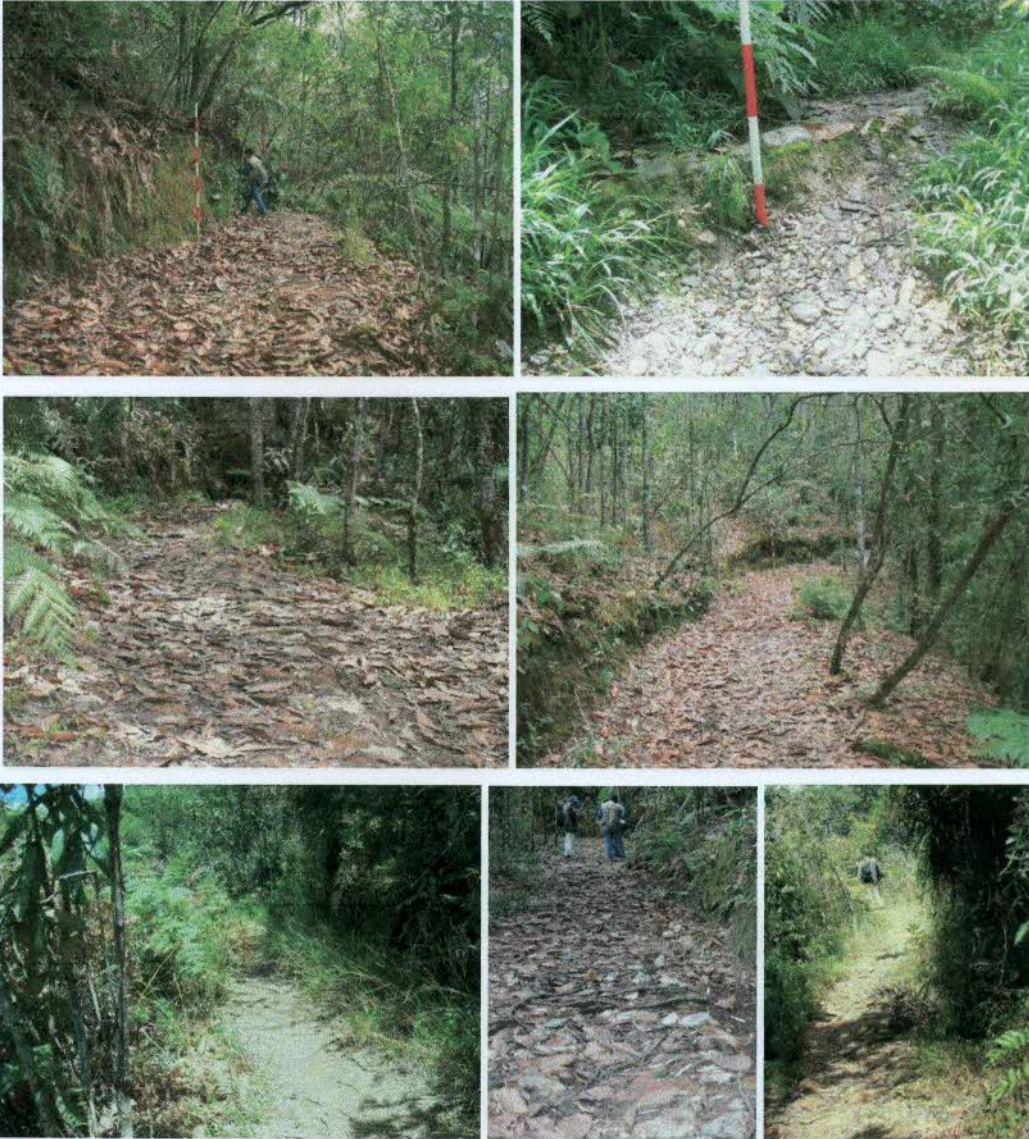
Foto 41. Calzada y estado de la carpeta en el trayecto
