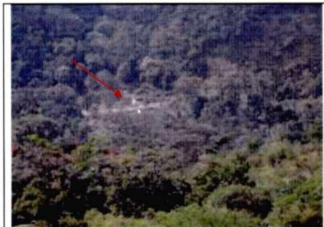
Foto 1. Vista panorámica Concesión BCO-151 y HF7-083. Zona de planta de triturados.
