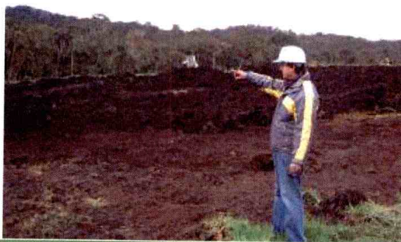
Foto 6: Monitoreo obras pozo Sueva-1.
