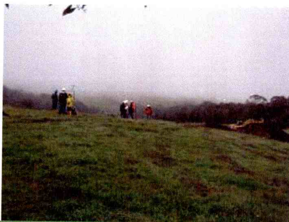
Foto 8: Panorámica obras pozo Sueva-1.
