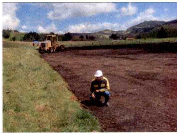
Foto 14: Panorámica obras pozo Carupa-1.
