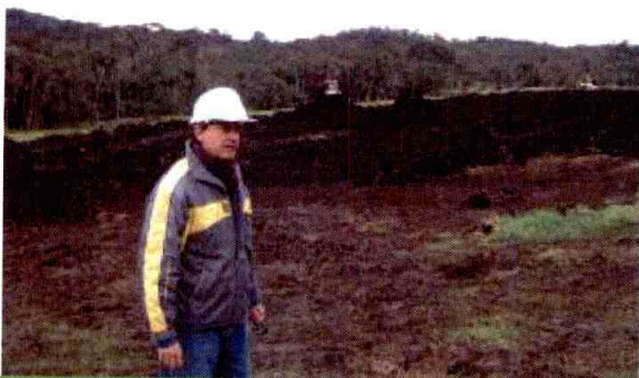
Foto 5: Monitoreo obras pozo Sueva-1
