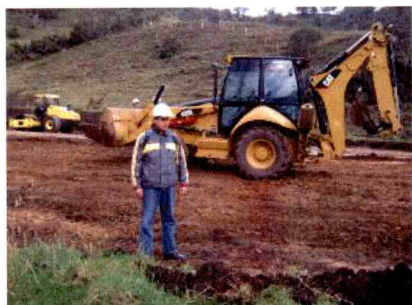
Foto 3: Monitoreo obras área de campamento.
