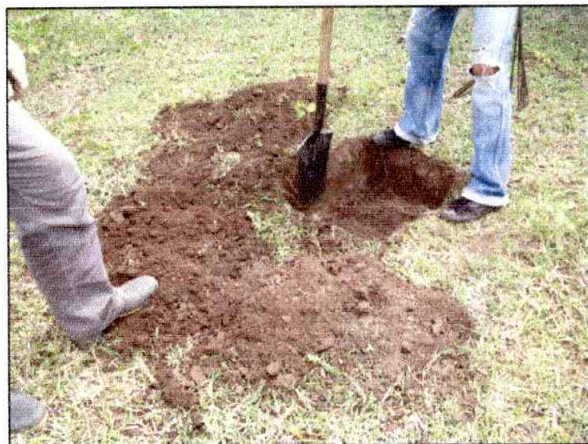
Foto 35. Apertura pozos de sondeo UIA 6.
