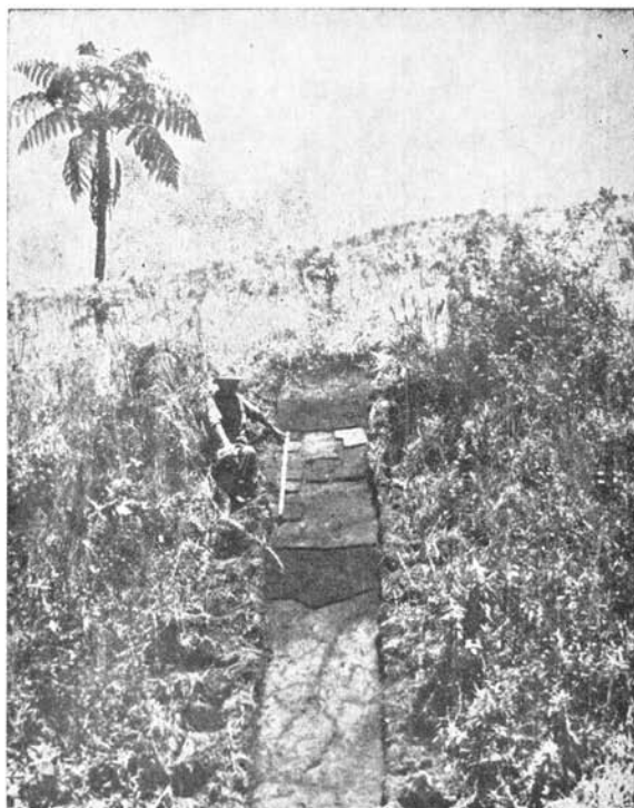
b) Corte en el talud de la carretera en el declive sur. Obsérvese lo delgado de la capa de construcción en adobe y relleno sobre la capa vegetal de base.
